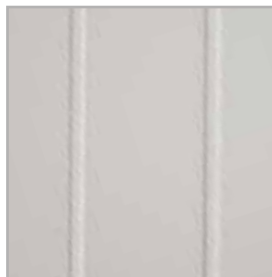
frezowanie na powierzchni skrzydła
