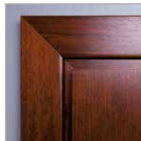
łączenie opasek pod kątem 45°
